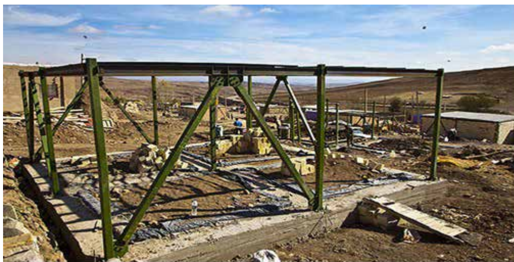
قاب فولادی با پیچ‌ومهره (قاب‌های فولادی در کارخانه ساخته می‌شوند)
